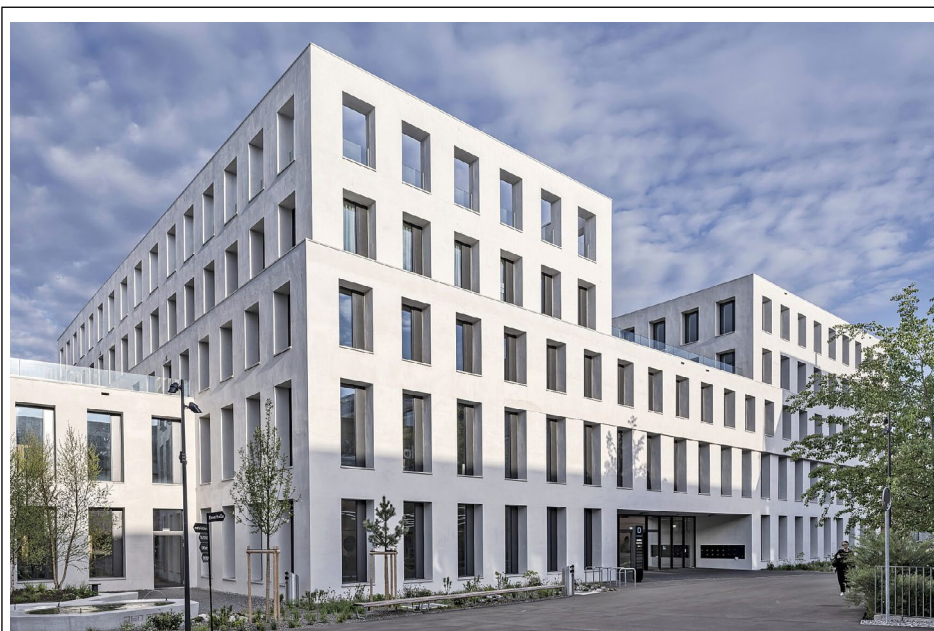
Fotografia 2. Budynek JED Schlieren, Szwajcaria.
